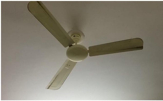
部屋のエアコン（シーリングファン） ダイヤルで、羽の回転速度調整が可能
