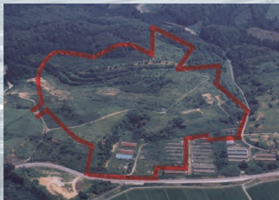
建設予定地となった旧辰口町旭丘
