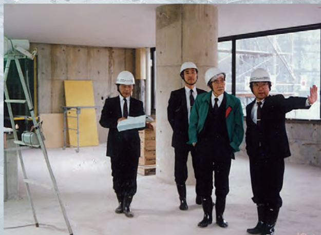
講義棟建設状況 (1991年10月)
