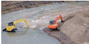
写真3：斐伊川において、土砂が枯渇する河川環境を改修するための「土砂還元」の様子
